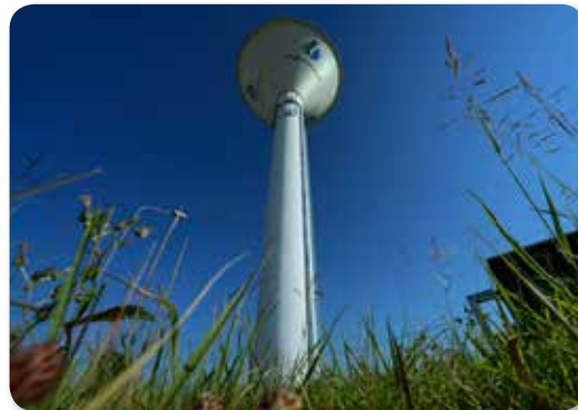
Il serbatoio pensile della centrale di San Donato (Parma)
